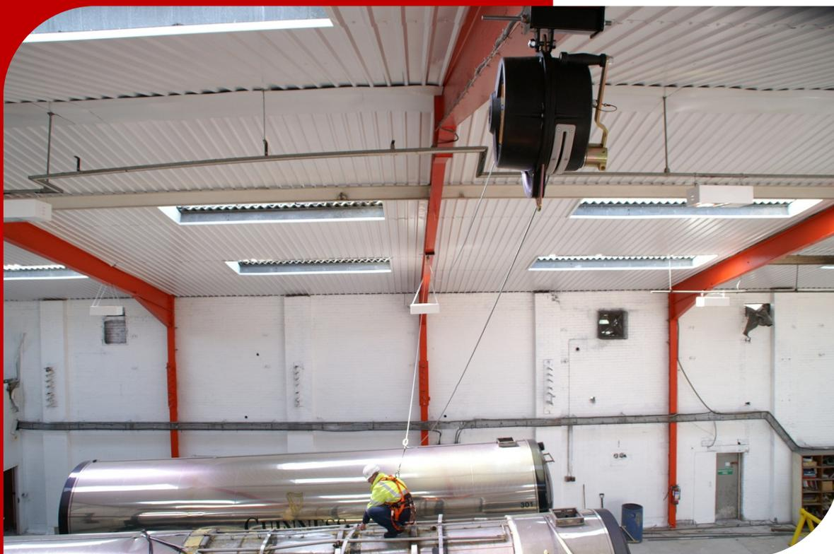
Zugang wird oben und an den Seiten benötigt. Die Auffangstrecken sind zwangsläufig kurz und Bewegungsfreiheit ist äußerst wichtig.
